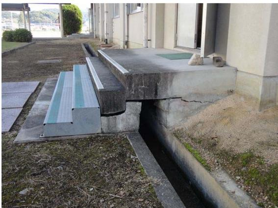
階段を2段継ぎ足すぐらいの沈下です。ひび割れ、壁のはがれなど、とても学校だけでは対応しきれないと思います。
